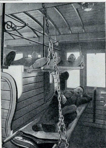
INSTALLATION DE BRANCARDS DANS UNE VOITURE DE 3 e CLASSE
