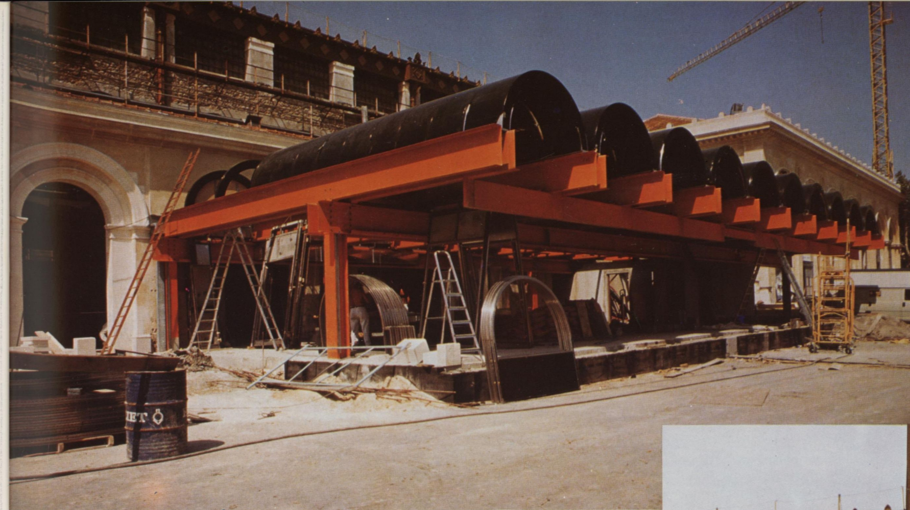
La brasserie : détail de l'ossature et des coques en acier inoxydable.
