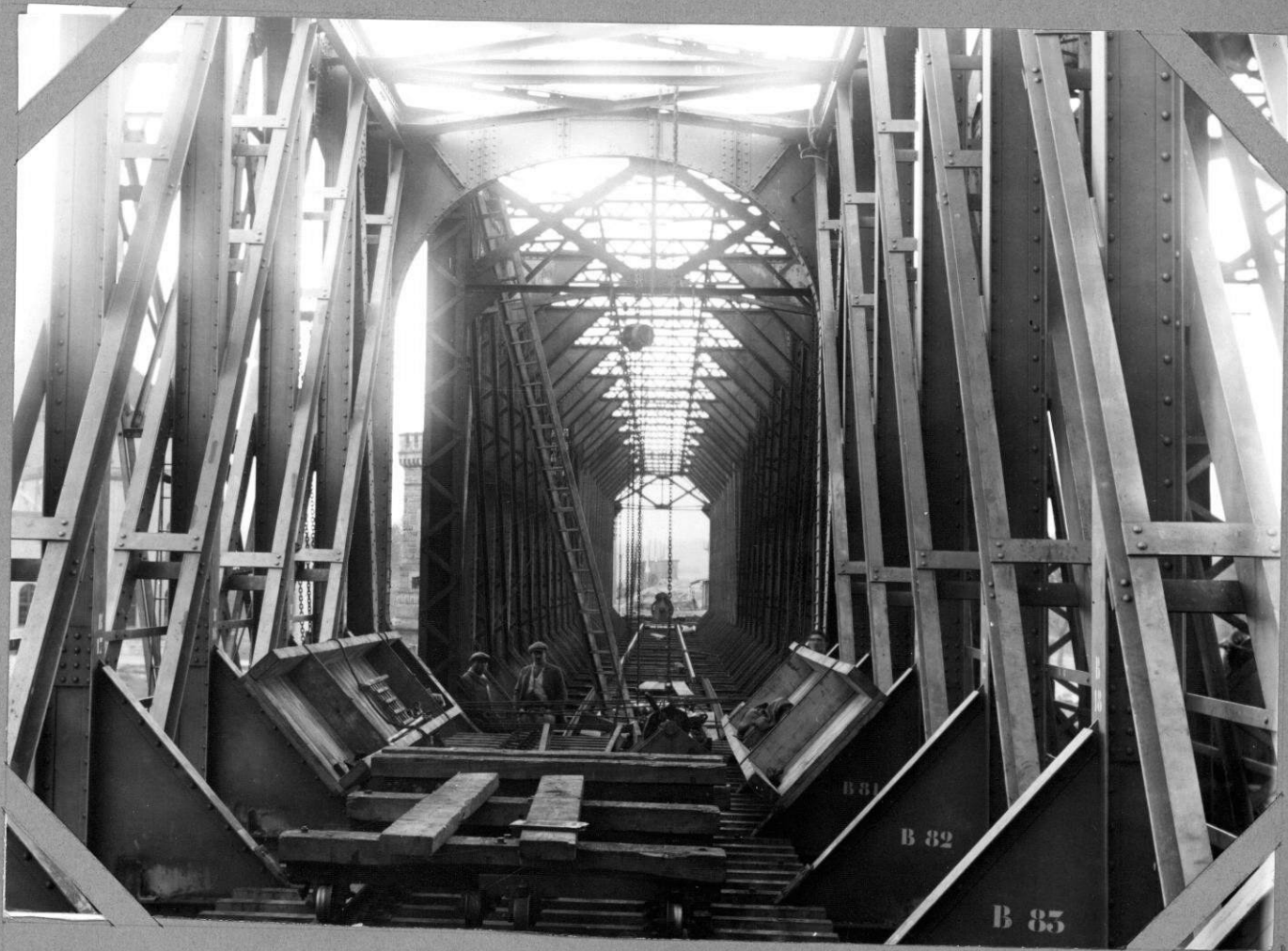
Dépose du tablier métallique fin du ripage du tablier en fer de 1ère travée 21-4-1938
