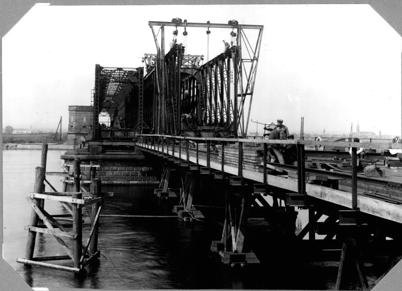
Dépose du tablier métallique Démolition du 1 er tablier en fer 5 - 5 - 1938
