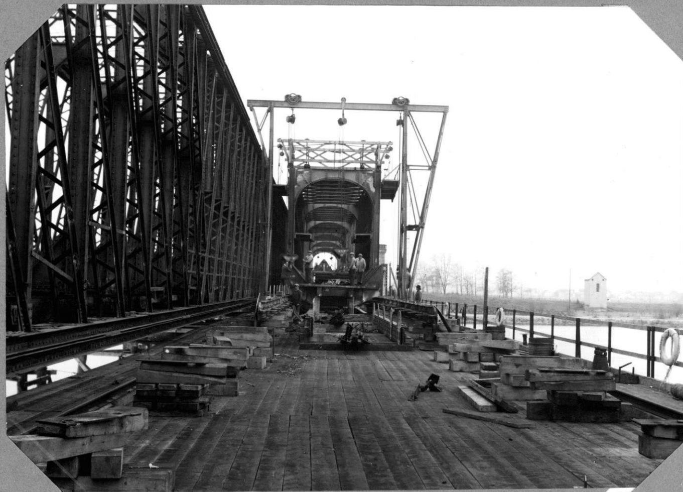
Dépose du tablier métallique Démontage de la travée "A" en acier 14-4-1938
