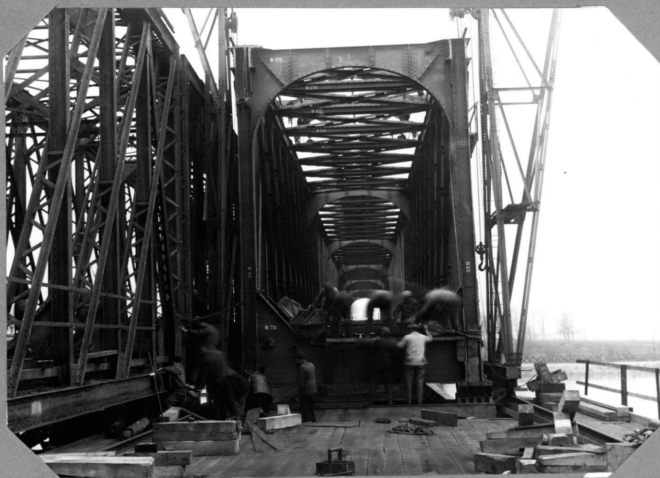
Dépose du tablier métallique Mise en place du dispositif de rîpage du vieux tablier 21-4-1938
