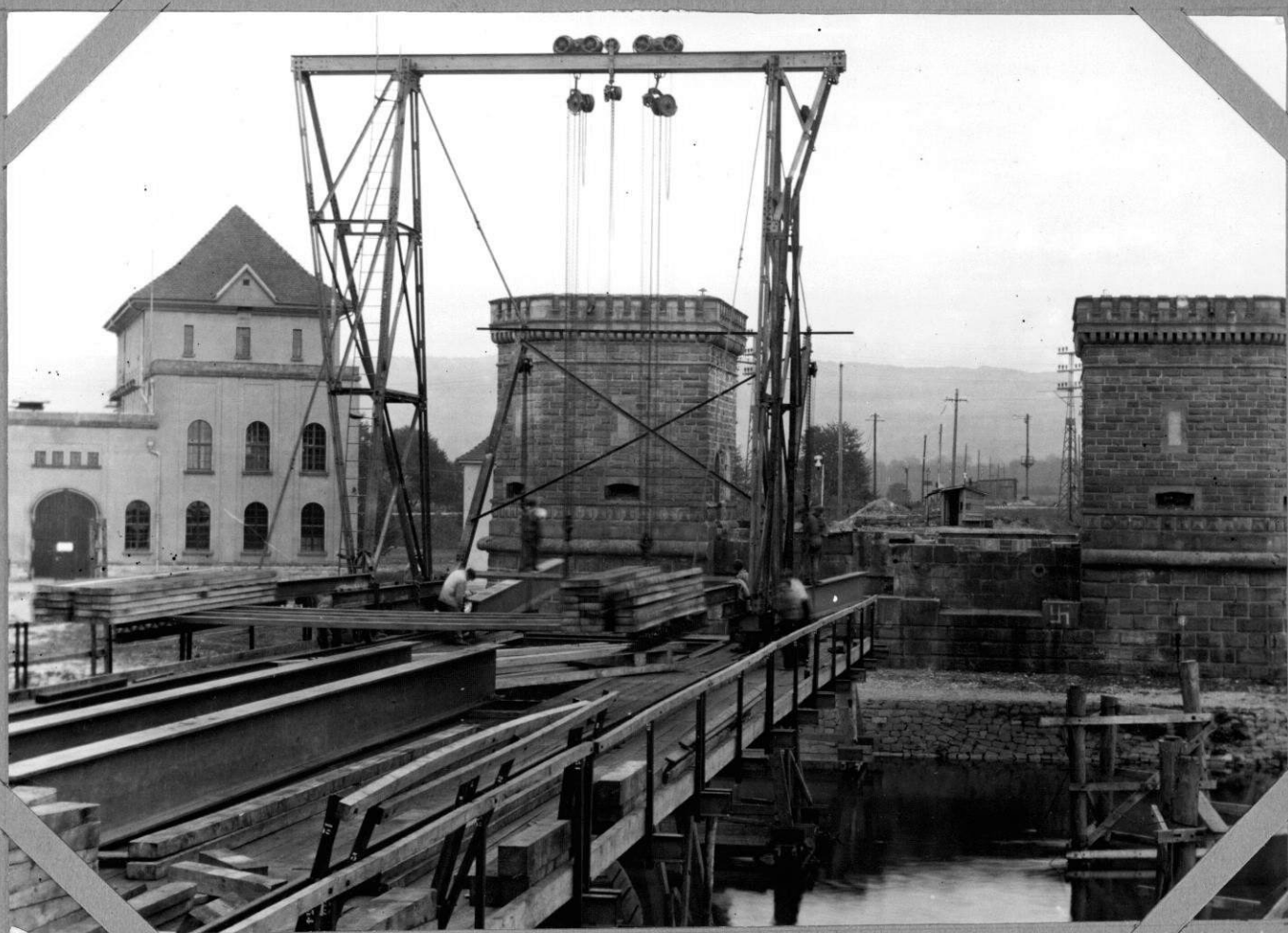
Dépose du tablier métallique Enlèvement des poutrelles d'échafaudage 9 - 5 - 1938
