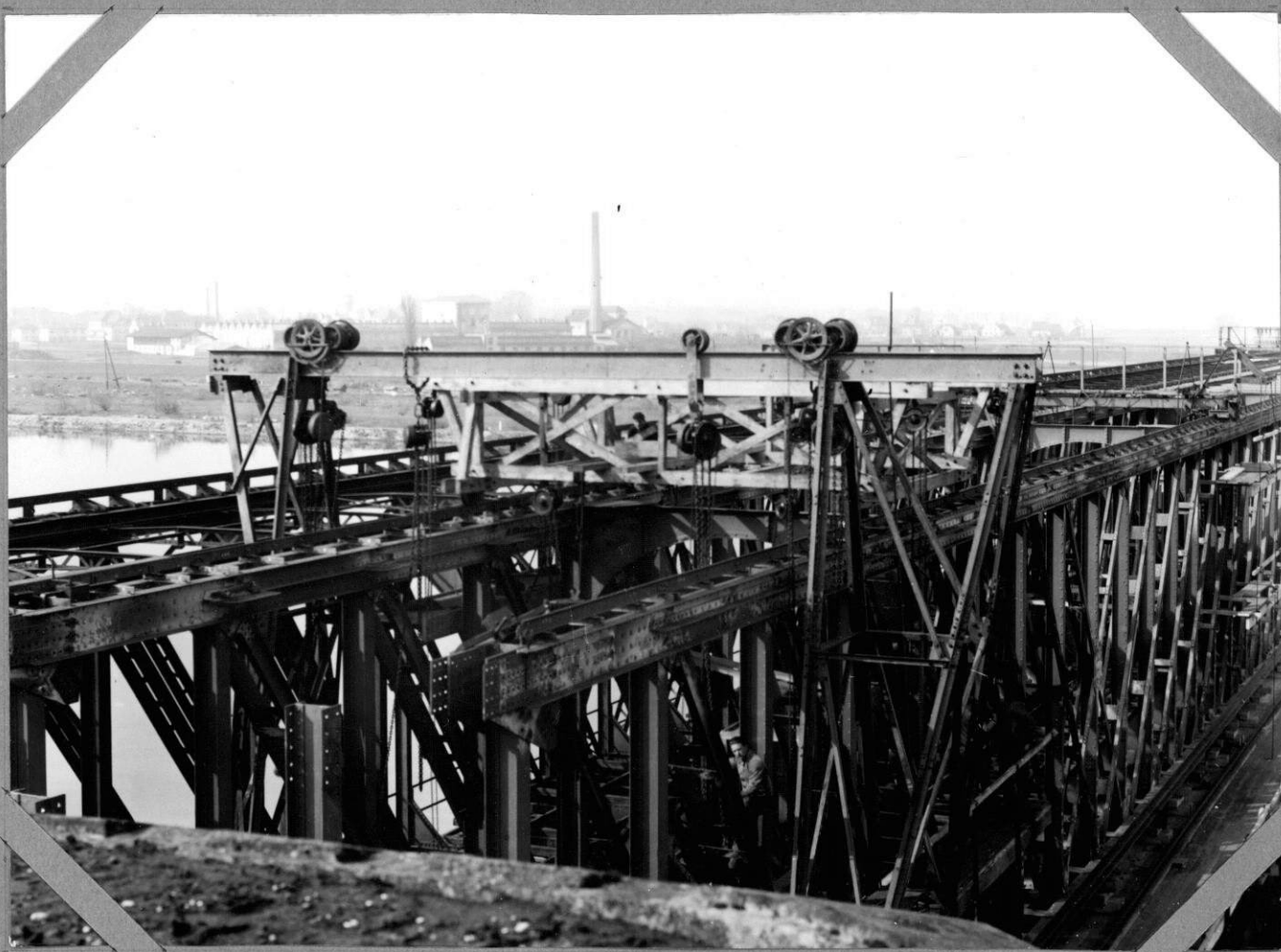
Dépose du tablier métallique 1 ère travée , rive allemande, en cour de démontage Vue d'ensemble 21 - 3 - 1938
