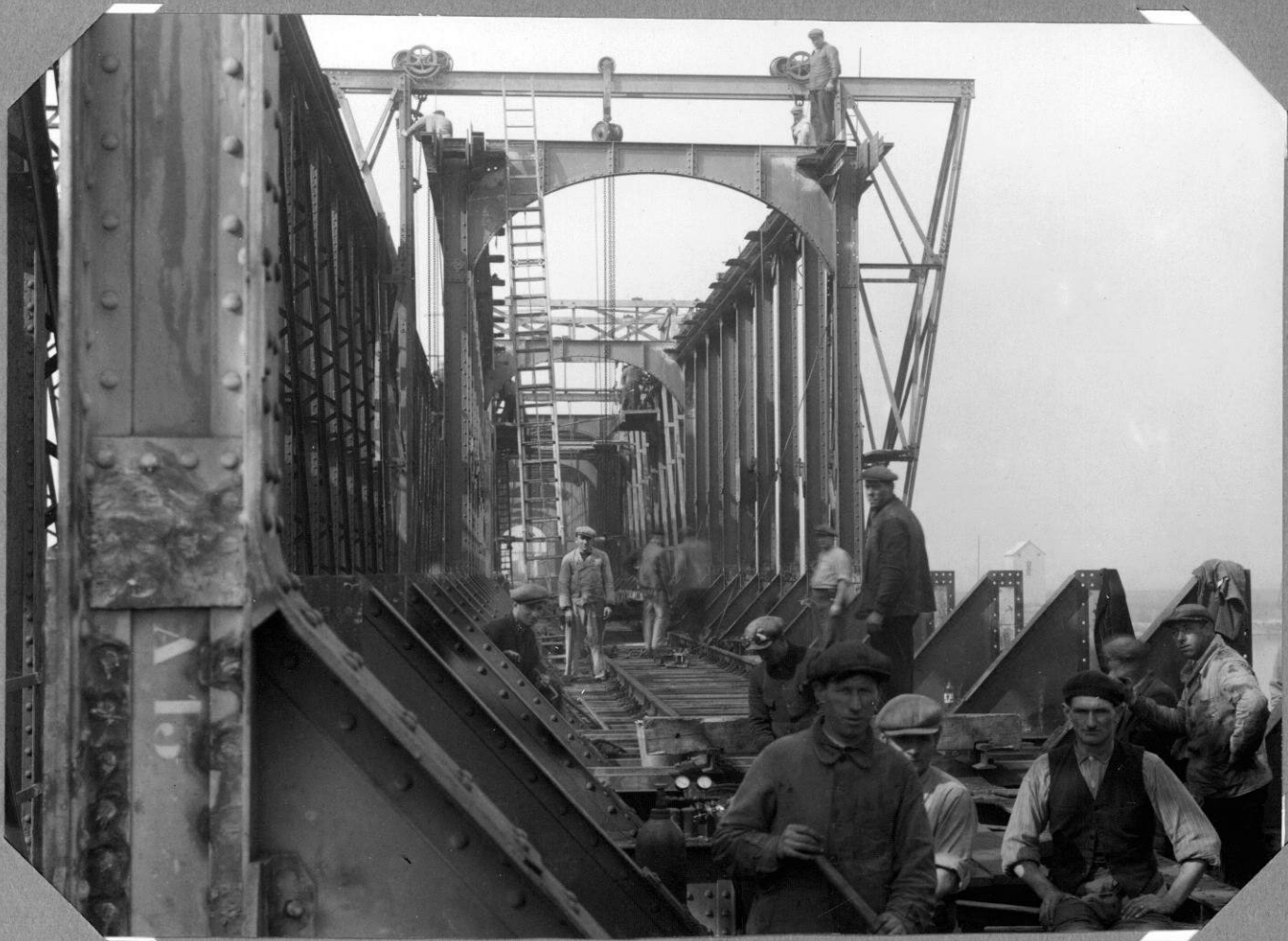
Dépose du tablier métallique Démontage de la travée rive droite 29-3-1938
