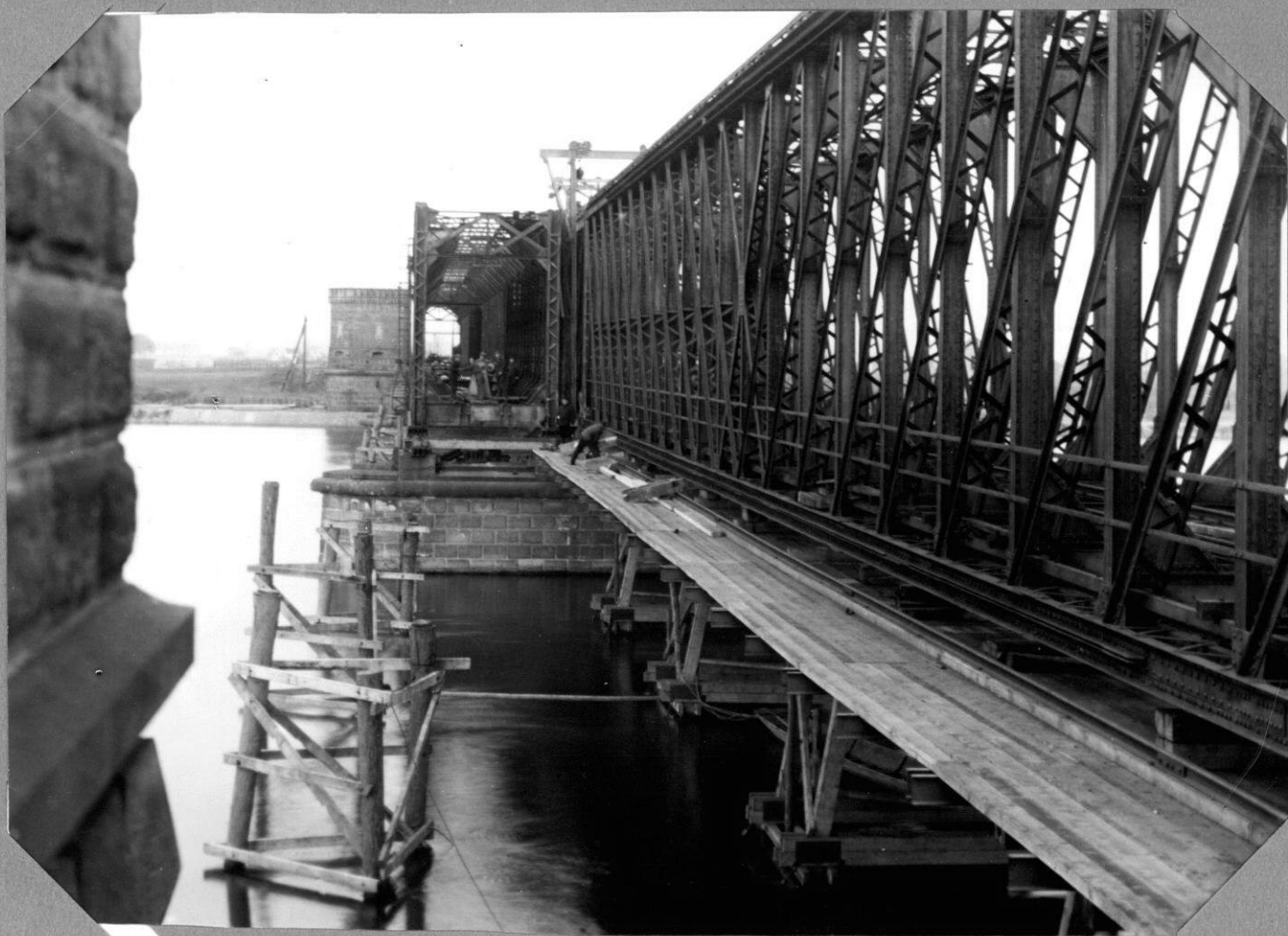
Dépose du tablier métallique Vue d'ensemble après ripage de 1 er travée en fer 21-4-1938
