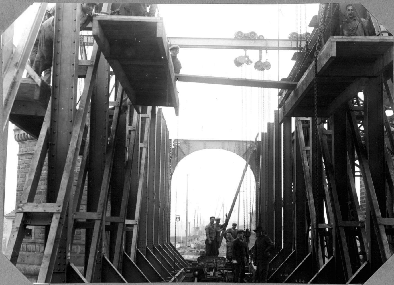
Dépose du tablier métallique 1ère travée, rive allemande, 1 tronçon des membrures supérieures enlevé 21-3-1938
