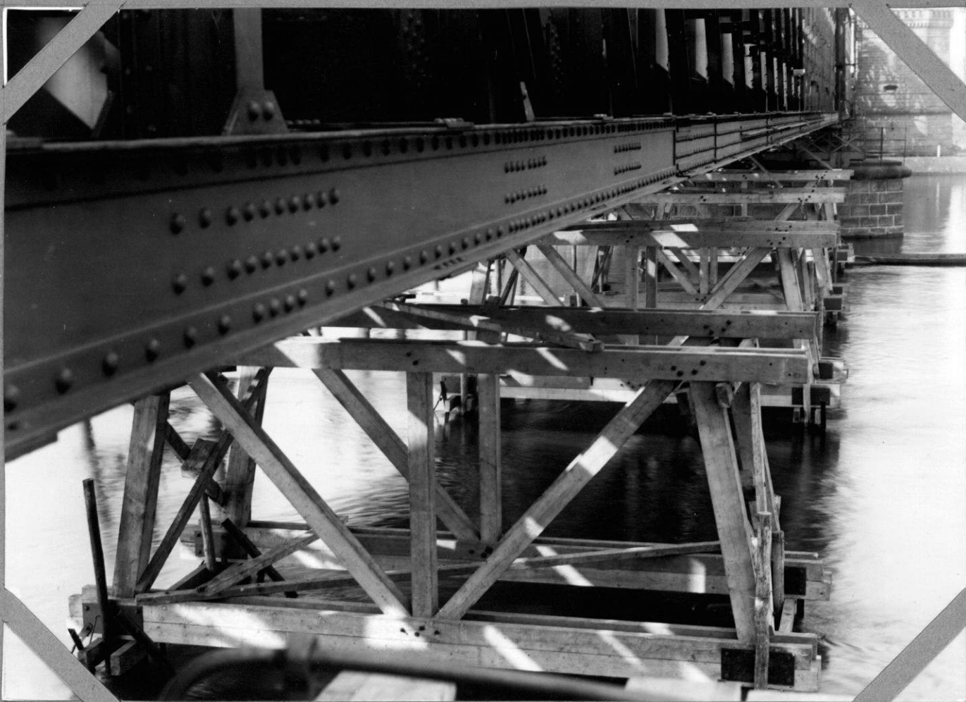
Dépose du tablier métallique Echafaudages sous la travée centrale 21-3- 1938
