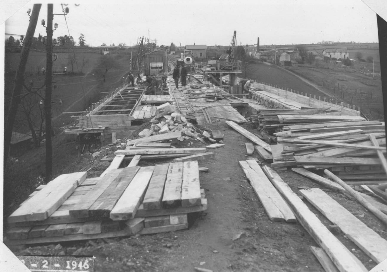
Vue de dessus prise côté La Possonnière. — Ferrailage de la plinthe. —
