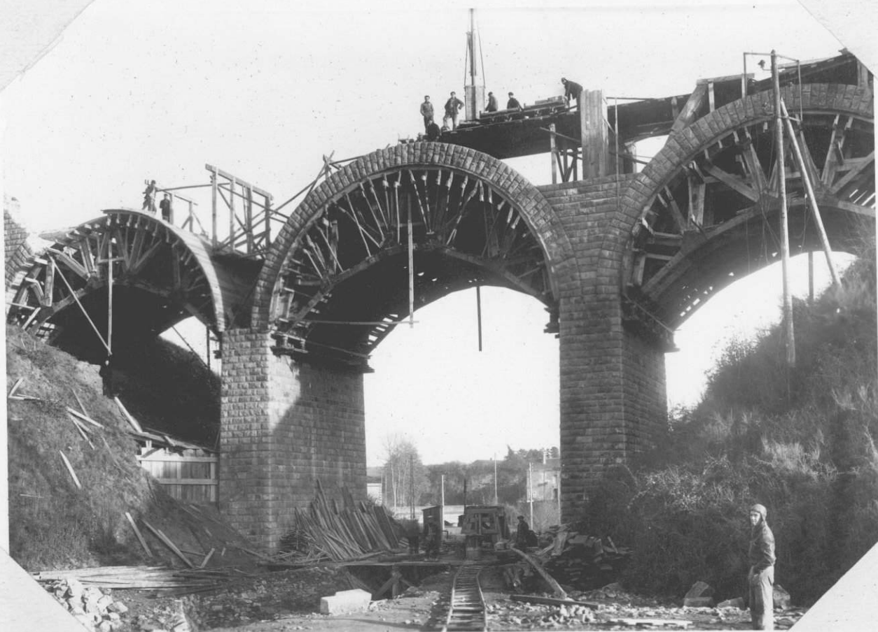
— 1 er PONT SUR L'HYRÔNE. Maçonnerie de la douelle et des bandeaux de voûte. — VUE CÔTÉ OUEST
