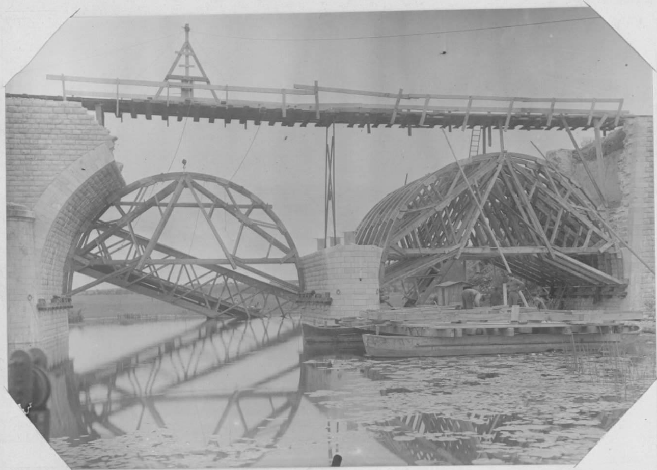
Assemblage et mise en place des cintres . - 6.6.46 -
