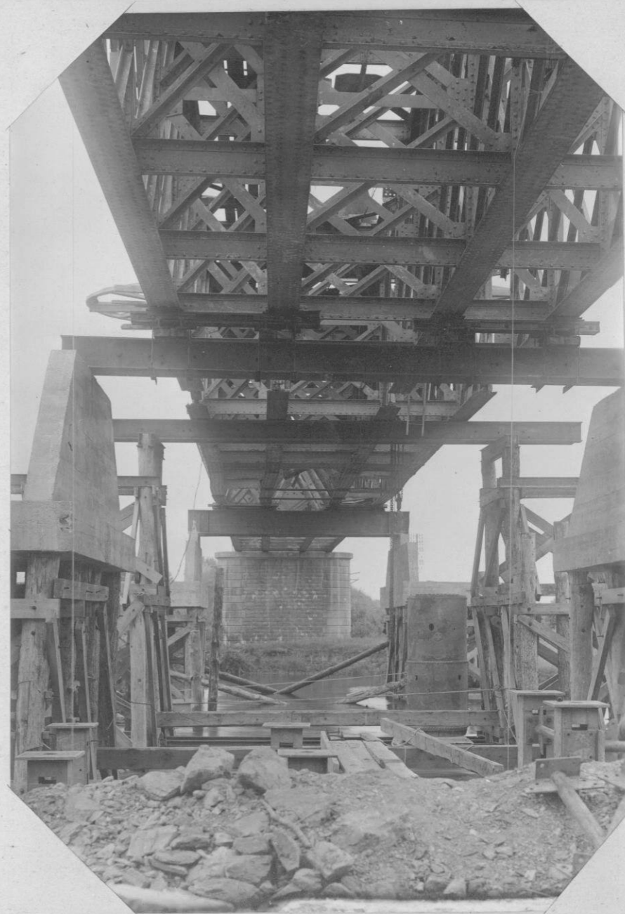
Vue de la déformation des poutrelles du T.M. - (6.6.46)
