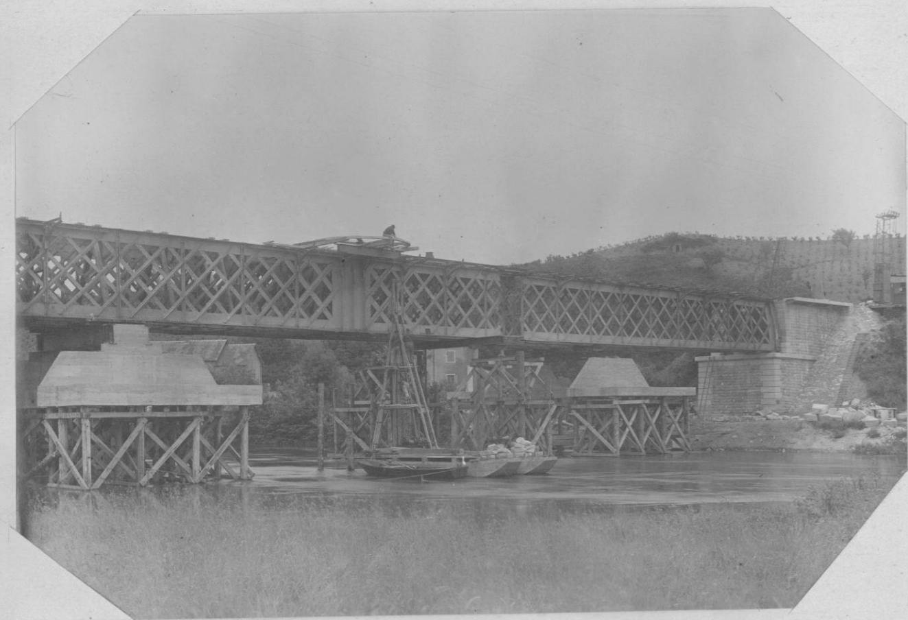
Vue de la culée après réfection des travaux préparatifs au battage des palplanches pour la reconstruction de la pile. - (6.6.46.)
