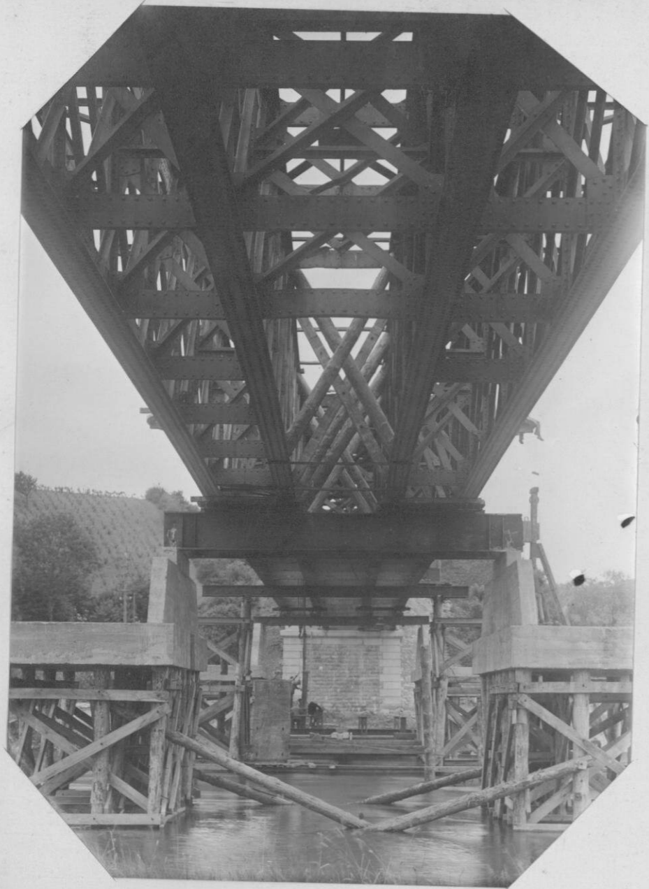
Vue de la déformation des poutrelles du T.M. (6.6.46) -
