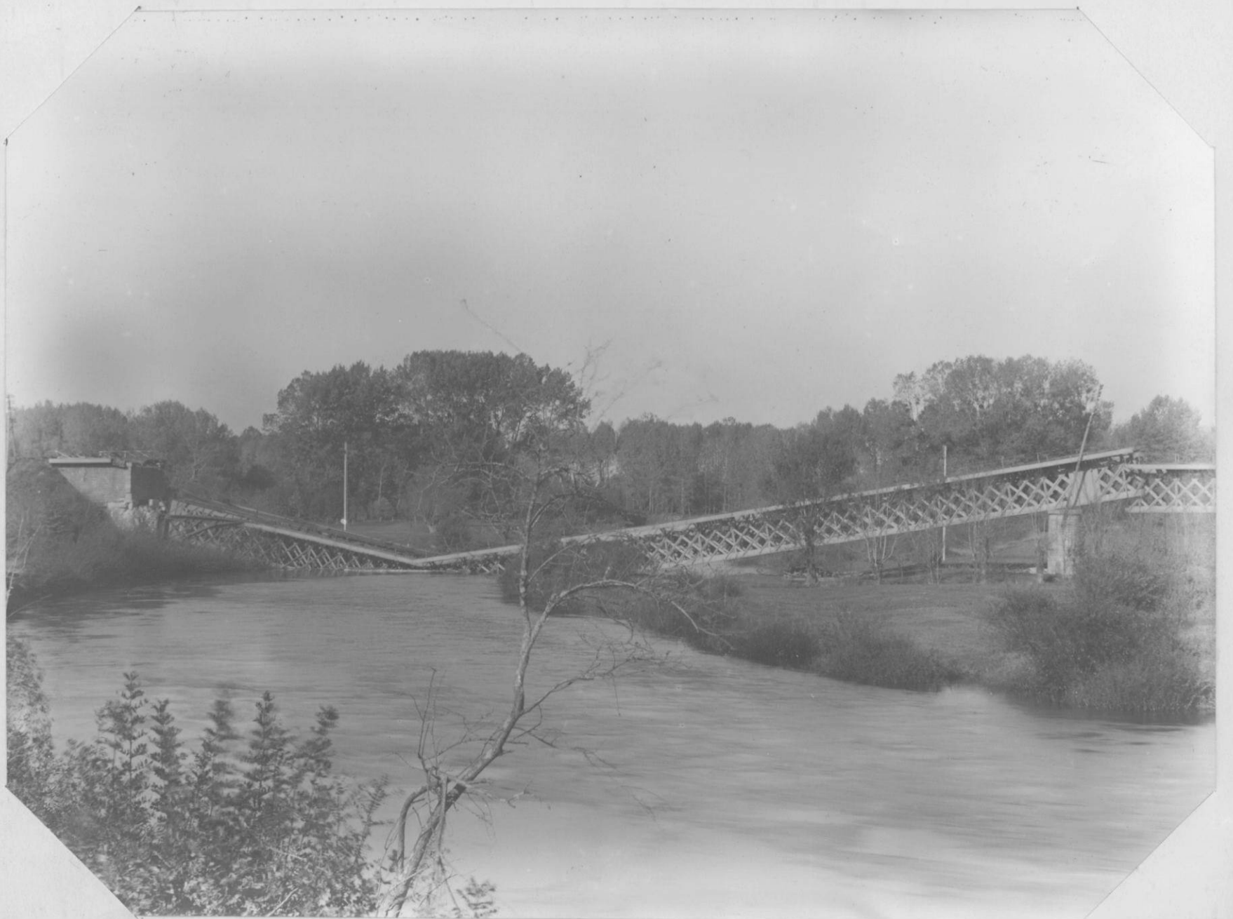
Pont sur le Louet au km: 4+420. Vue du côté impair. le 5.10.44.
