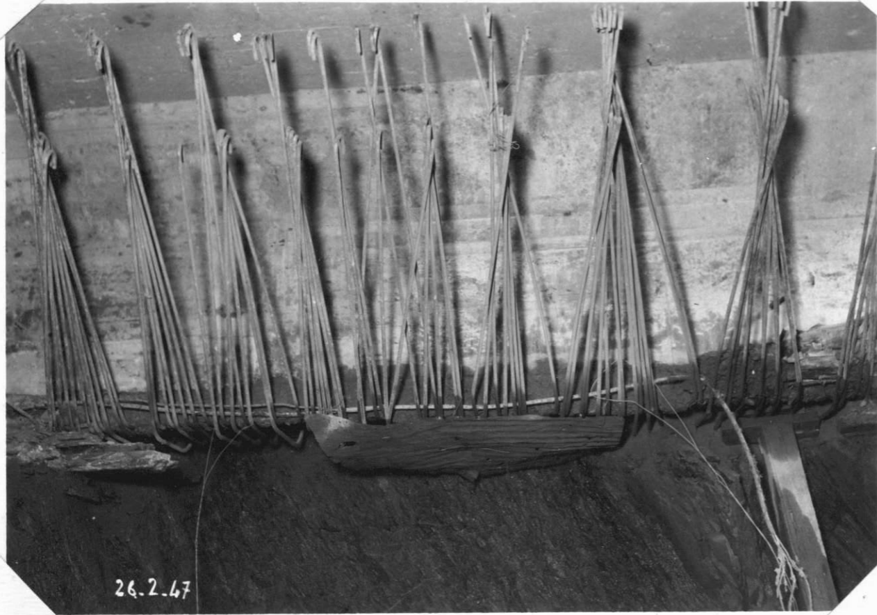
Partie en sous-œuvre.. Barres en attente sous la retombée de la voûte.
