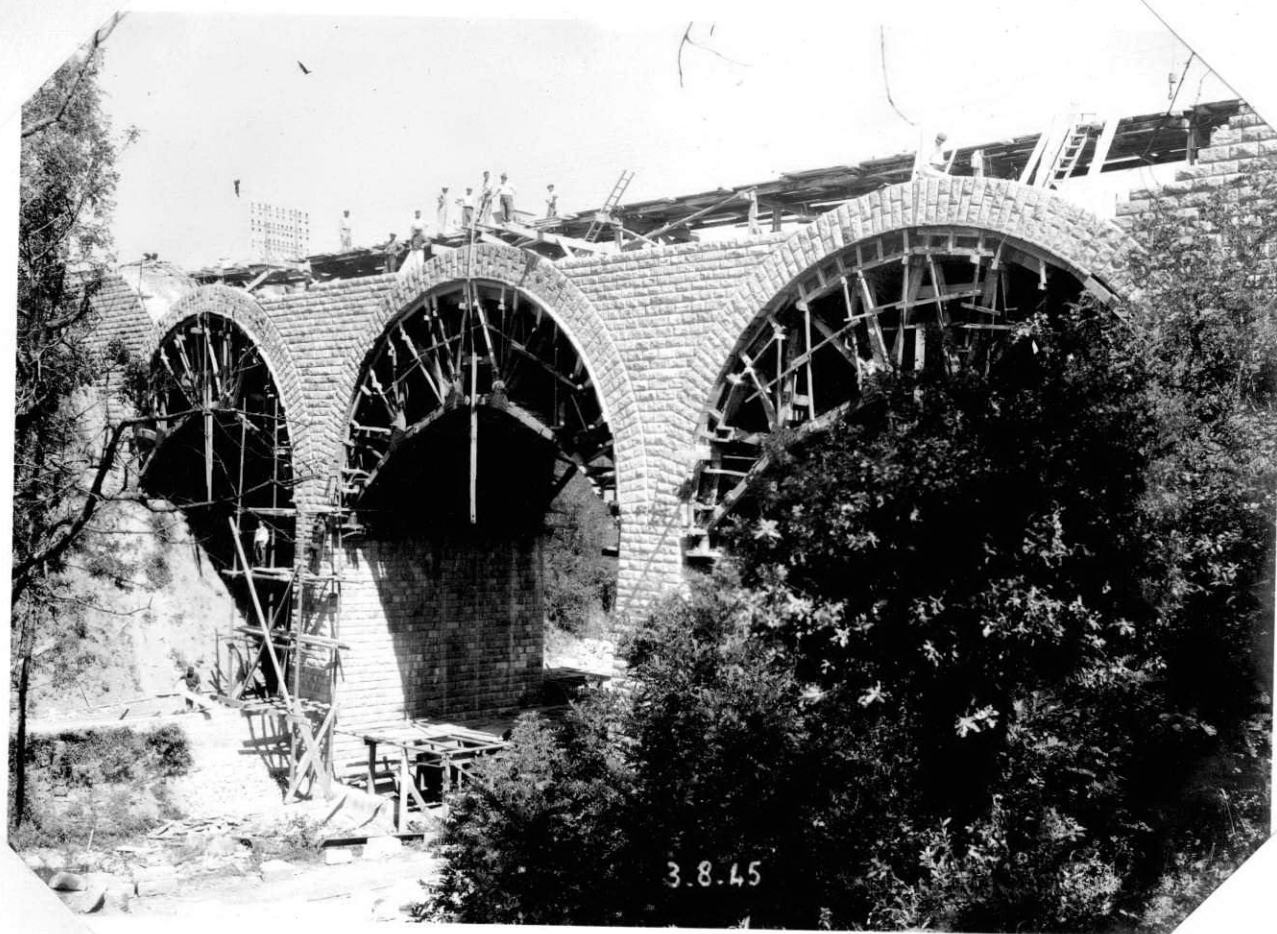
- Vue d'ensemble - Maçonnerie des tympans -
