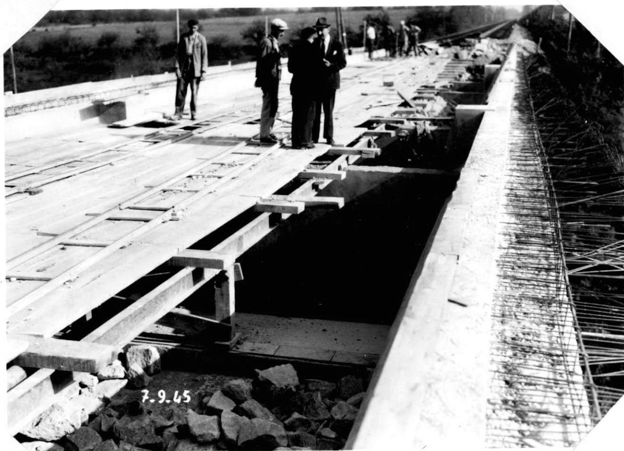
Remblaiement du Pont - Côté Nantes -
