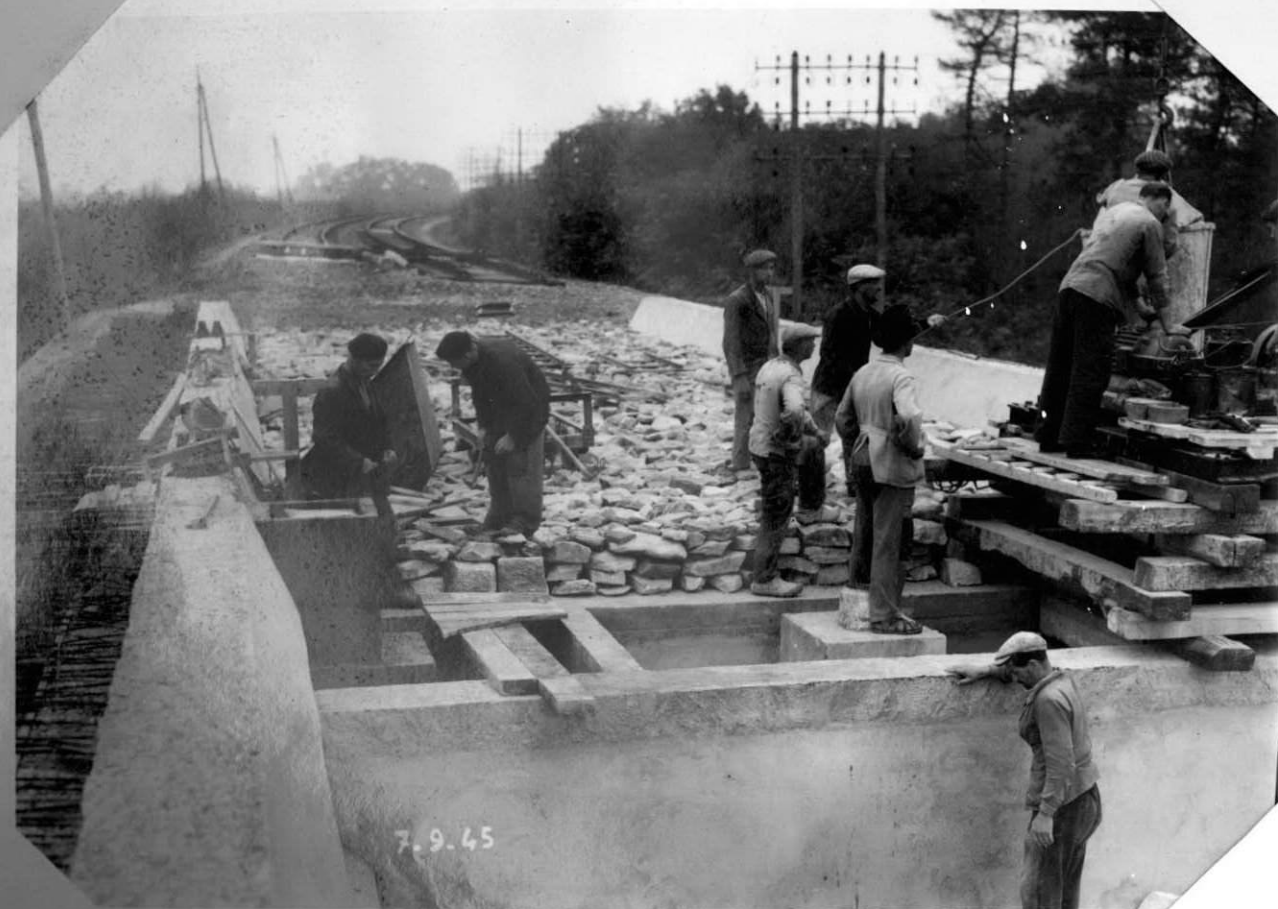
- Le 7.9.45. Culée remblayée et ferrailage des trottoirs -
