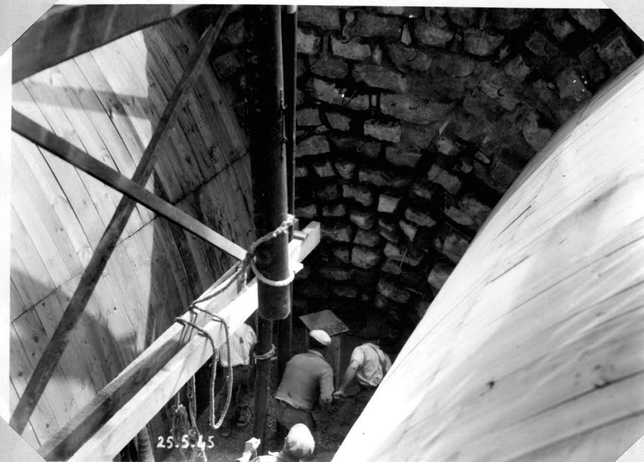
Bétonnage des Voutes à la naissance - Vue prise le 25.5.45
