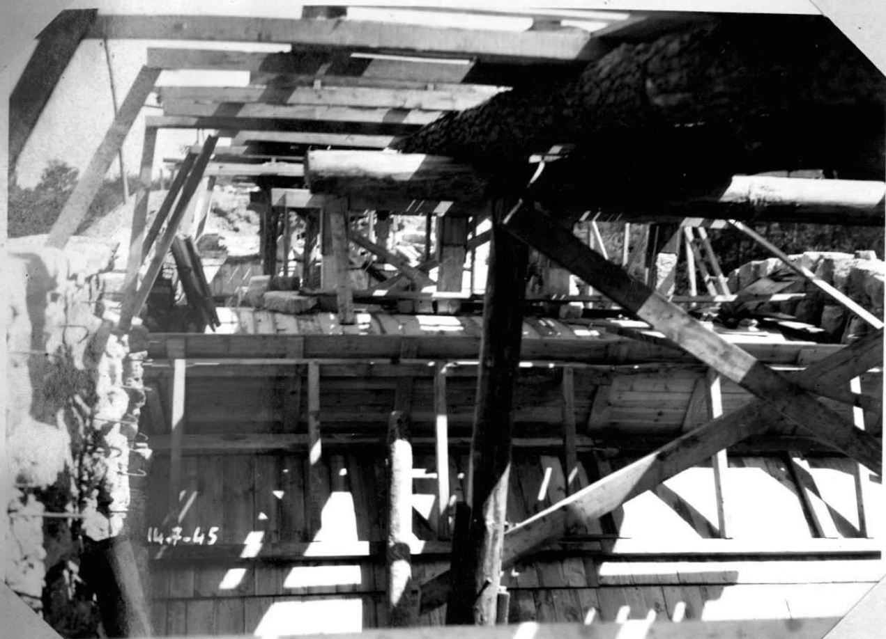
Intérieurs des tympans. et dessus du coffrage des voûtes
