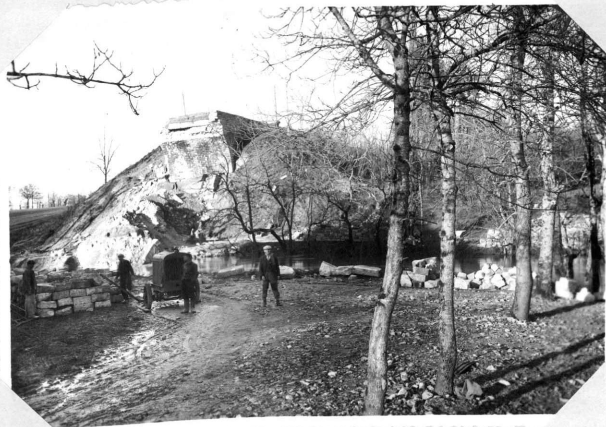
- Pont de Montaigu. Vue Fmont. le 7.12.44. - - Culée côté Nantes -
