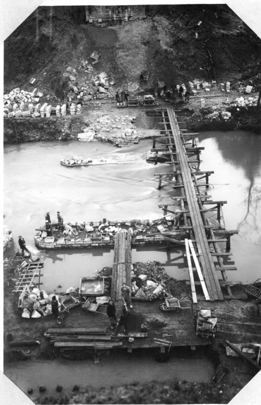
- Fondations des piles - le 19.1.45.
