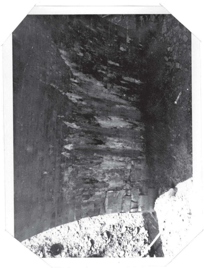
Voûte N°5 - Culée R.D. - (Août 1946)
