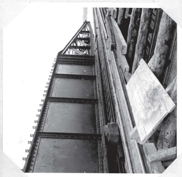
- Passerelle avant lancement - - Le 29.12.44 -
