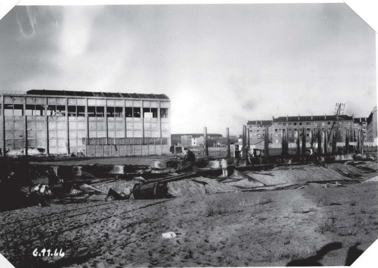
Tablier en cours de dépose. le 6.11.44
