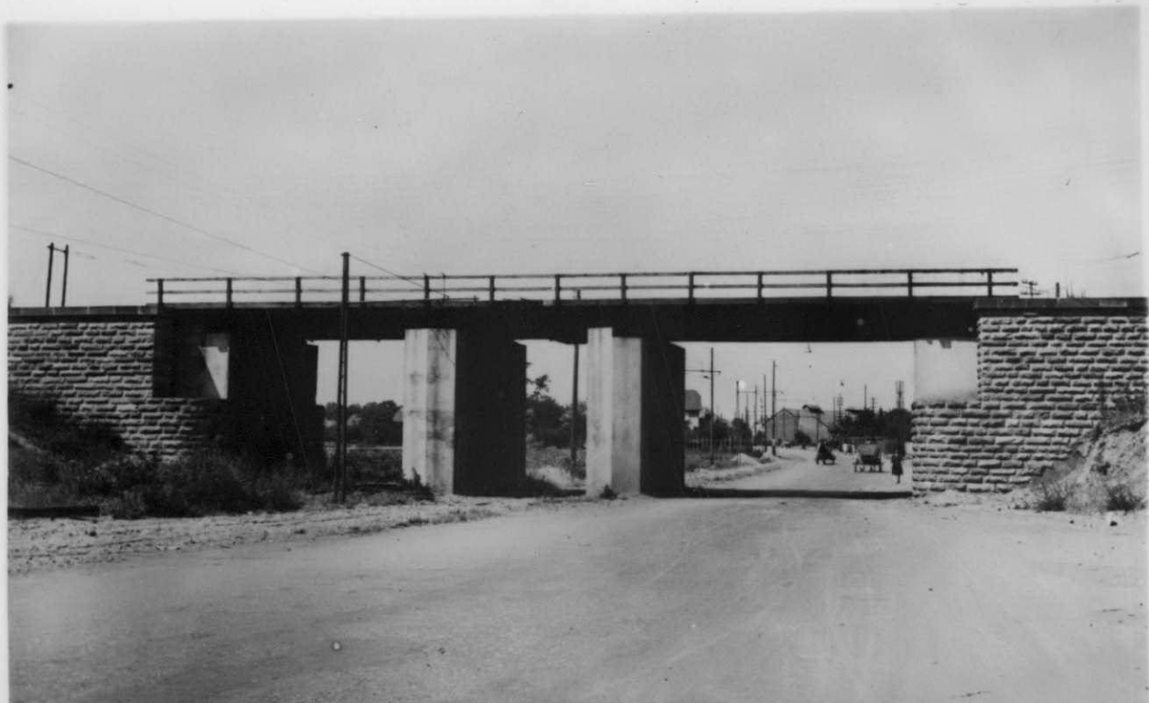
N° 71 Ligne de Luttlbach à Rixheim. P.I. du P.K. 6.800. Route de Sausheim.
