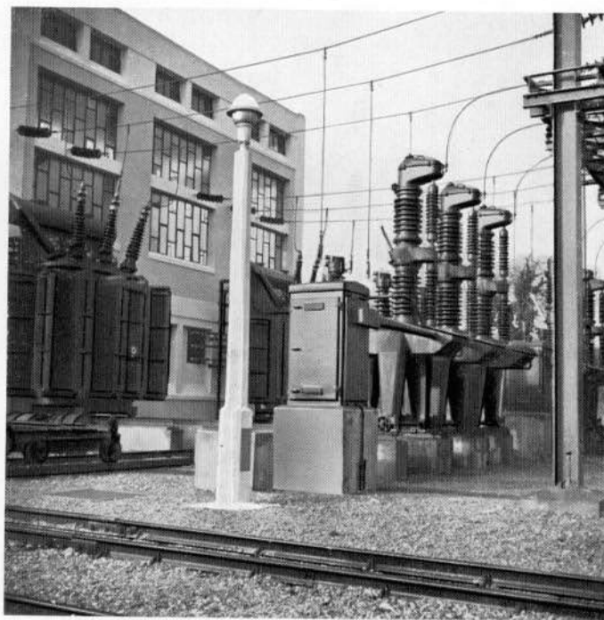
Disjoncteur à 90 kV à volume d'huile réduit
